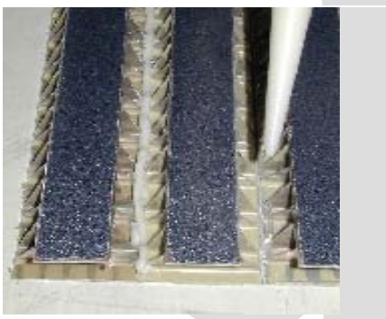
Fig. 3.2.E Collage dans la rainure
