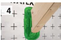
Dérouler la bande, enlever le film protecteur et guider tout en appuyant à la main. Respecter la hauteur min. de raccordement selon réglementation / norme. Veiller à ce que le PAVATAPE FLEX ne soit pas étiré (possibles forces de retrait). Presser fortement avec le rouleau.
