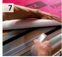
**Raccordement de tuyaux étanches à l'air et à l'eau grâce au PAVATAPE FLEX (6)/PAVATAPE 150 (6a)**
