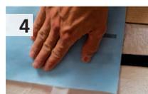
**Bande en caoutchouc butyle, adhésive sur une face, très souple, pour l'étanchéité durable et simple des panneaux et lés PAVATEX au niveau des raccords avec les chevrons, les pannes, les tuyaux de ventilation etc, en intérieur et extérieur. Pour le collage sur des panneaux en fibres de bois et d'autres supports poreux ou minéraux, il faut toujours appliquer au préalable une couche de PAVABASE/ PAVAPRIM.**
